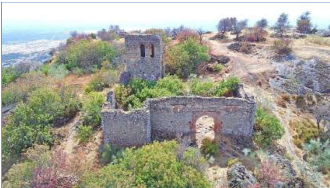
Vista de los restos de la iglesia/ermita desde el norte (Autores)
