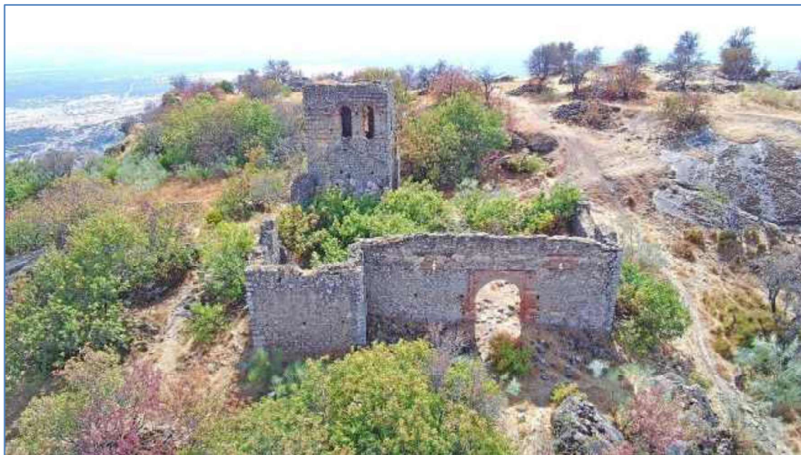
Vista de los restos de la iglesia/hermita desde el norte (Autores)
